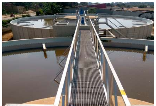
Puentes decantados (ETAP)
